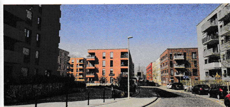
Am Probsthof ist die "Westside" fast fertig
