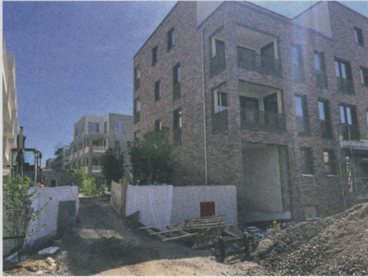
Wohnungsneubau im "Vogelsang": Von ziemlich viel Baustelle...
